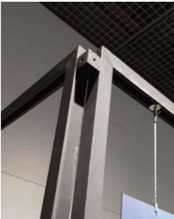
Eckverbindung einfache Rahmen / oben
