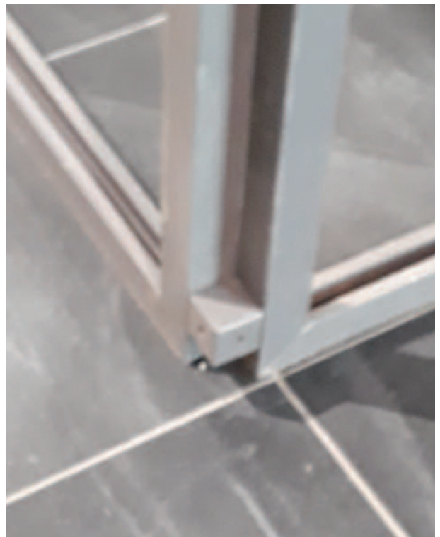
Eckverbindung einfache Rahmen / unten
