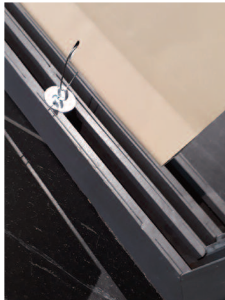
Metall-Plättchen verbindet die doppelten Rahmen miteinander
